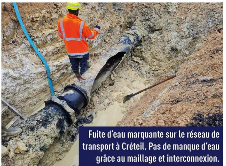
Fuite d'eau marquante sur le réseau de transport à Créteil. Pas de manque d'eau grâce au maillage et interconnexion.
