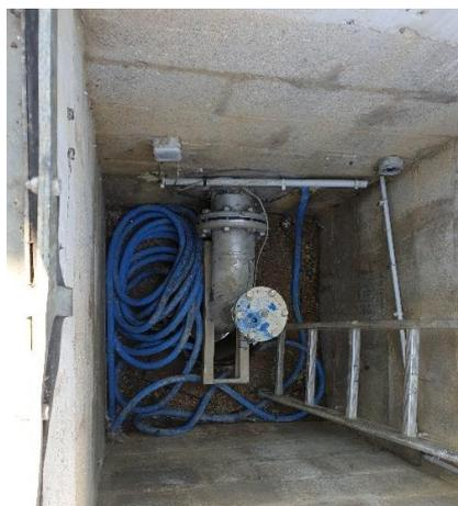
Afin de garantir la qualité bactériologique de l'eau produite, une désinfection au chlore gazeux est effectuée sur la conduite de refoulement (travaux modificatifs réalisés en 2010, la chloration se faisait précédemment par injection de chlore directement dans le puits).
